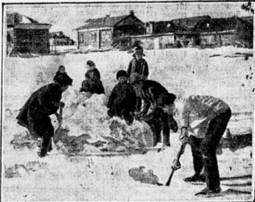
Пионеры деревни Сватково (Моск. губ.) роют канаву для стока весенних вод.
